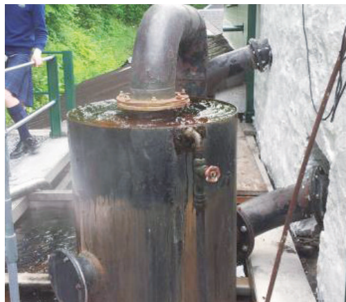
【그림 2-29】 웜 응축기(Worm Condenser)
