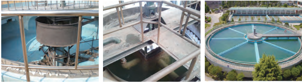
그림 5-8 원형침전지의 물 빠진 모습(좌), 2차 원형침전지 소형(중), 대형(우)
