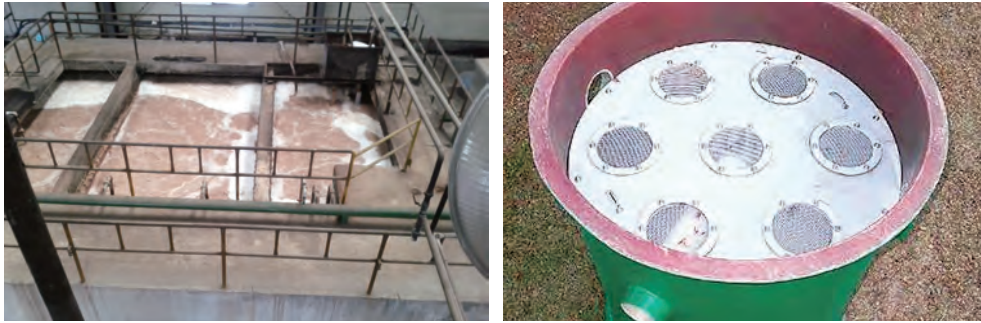
그림 5-7 폭기조(좌)와 공기를 주입하는 파이버글래스 장치(우)
